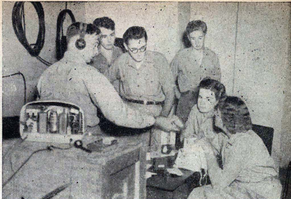
Iedere avond laten jongens van de Luchtstrijdkrachten achter het Koninklijk Meteorologisch en Magnetisch Observatorium te BATAVIA een radio-sonde op om in de hoge luchtlagen vochtigheid, temperatuur en luchtdruk te kunnen meten. Rechts: Twee toekomstige ML - luchtverkeersleiders krijgen „instructie radio-sonde”.
